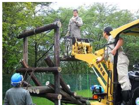
(重機で一つ一つ安全に撤去作業)
