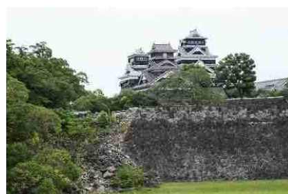
崩れた熊本城の石垣
