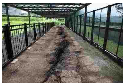
地表面に現れた活断層
