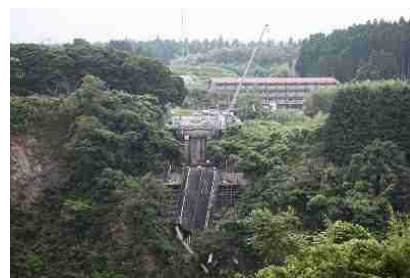
崩落した旧阿蘇大橋
