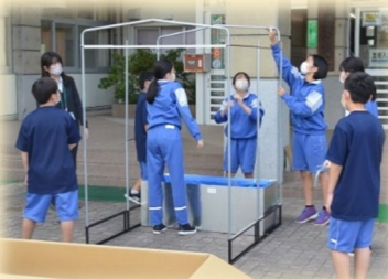
【仮設トイレの組み立て】
