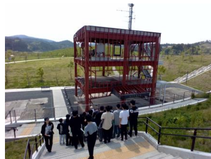
【震災遺構・防災庁舎跡】
